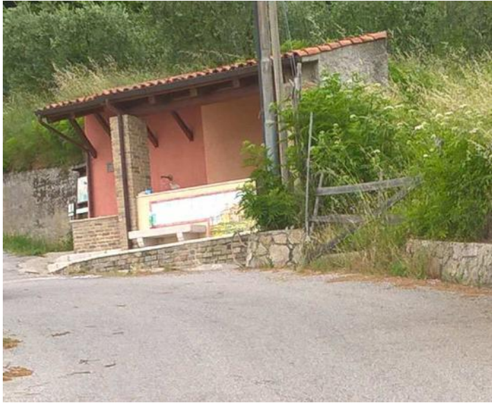
Figura 5-Lavatoio di recente ristrutturazione
